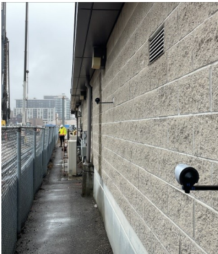
Prisme de surveillance du bâtiment
